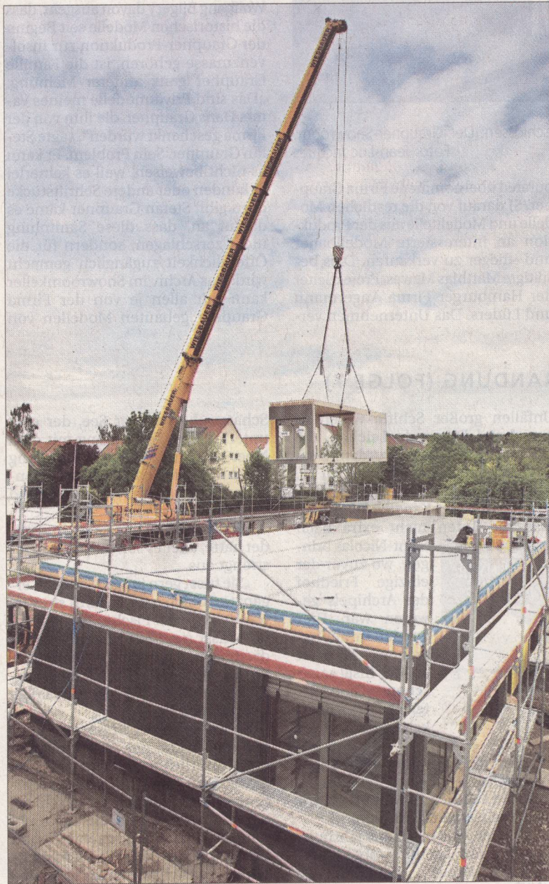
Nicht Stein auf Stein sondern Modul auf Modul schreitet der Bau der Kindertagesstätte Top-Kids voran. Foto: Jean-Luc Jacques
