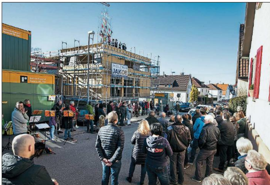
Der Rohbau ist fertig. Im September wollen Kirchengemeinde und Stiftung Tragwerk den neuen Martin-Luther-Hof beziehen. Foto: Holzwarth
